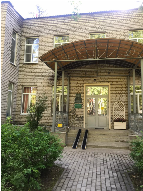
Вход в здание (крыльцо) ДОУ №2 №1
