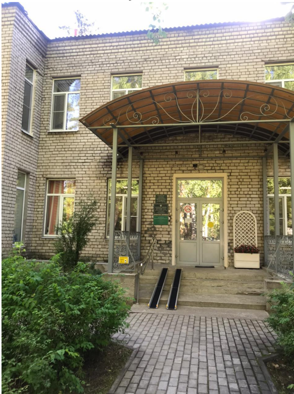
Вход в здание (крыльцо) ДОУ №2 №1
