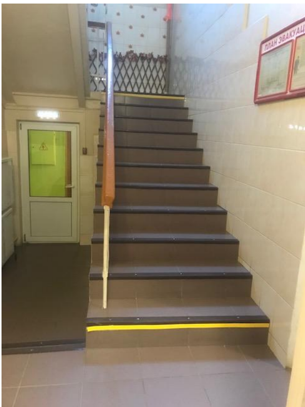
Лестница на 2 этаж ДОУ №2 №3
